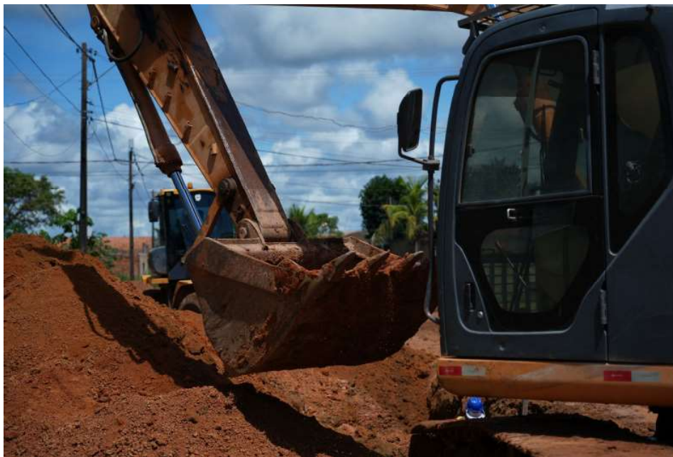
Serviços avançam com rede de drenagem concluída e início do asfalto previsto para agosto.
