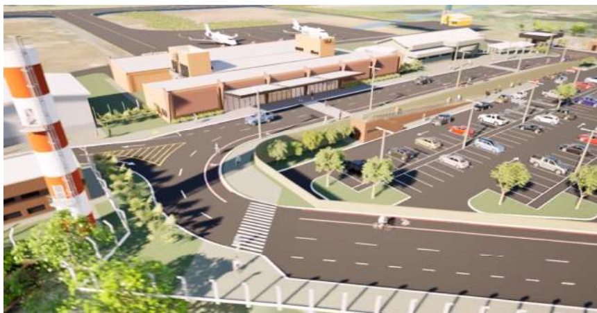
A execução da obra será acompanhada pelo Departamento Estadual de Estradas de Rodagem e Transportes (DER-RO).
