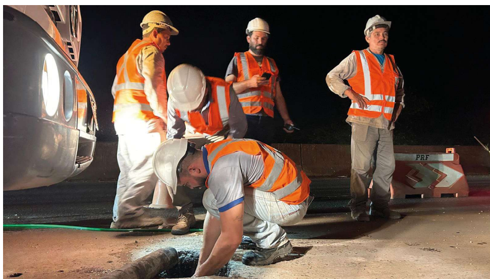
Obras na ponte seguem dia e noite, sem interrupção. Ainda não há uma data confirmada para liberação total
