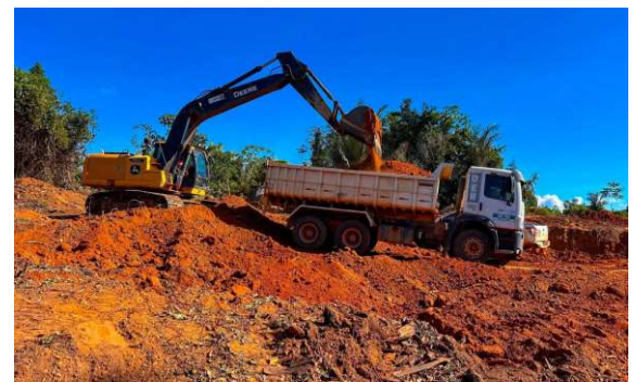
RO-133 em Machadinho d'Oeste recebe manutenção em 82 km realizada pelo governo do estado.
