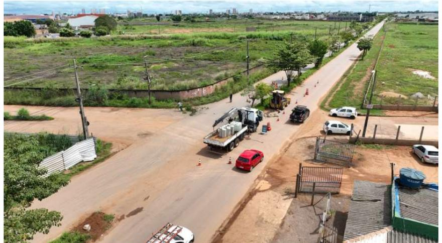
**Obra consiste na implantação de 88 postes metálicos de 12,5 metros cada um**
