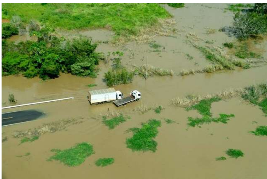
O trecho está interditado devido ao alagamento do igarapé Arara.
