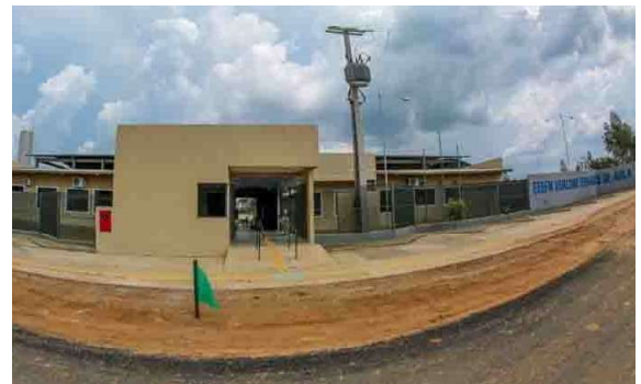
Melhorias na Escola Vivaldo Fernandes de Ávila, no distrito de Estrela.
